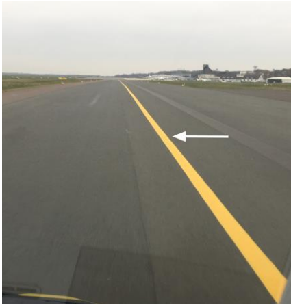
Rollbahnmittellinie in gelber Farbe (Rollbahn C - Blick Richtung Osten)
