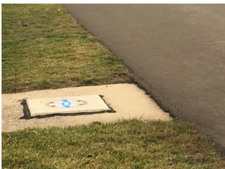
Rollbahnrandfeuer in blau (Unterflurvariante)
