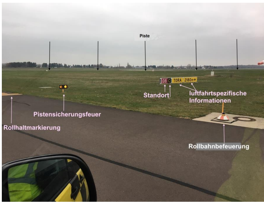
Kombination der oben genannten Markierungen, Beleuchtungen und Schilder auf/an einer Rollhalt-Position.
