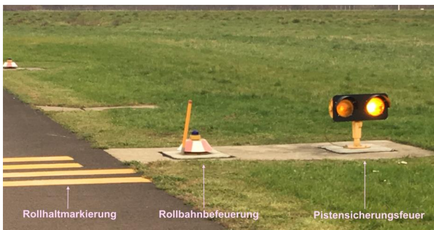
Pistensicherungsfeuer (Runway Guard Lights):
