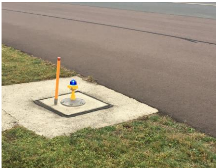
Rollbahnrandfeuer in blau (inkl. Schneemarker)
