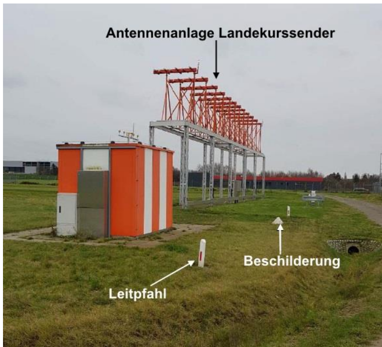
Foto des Landekursenders (LLZ) - Blickrichtung von Nord nach Süd; rechts im Bild die Rundumpiste.
